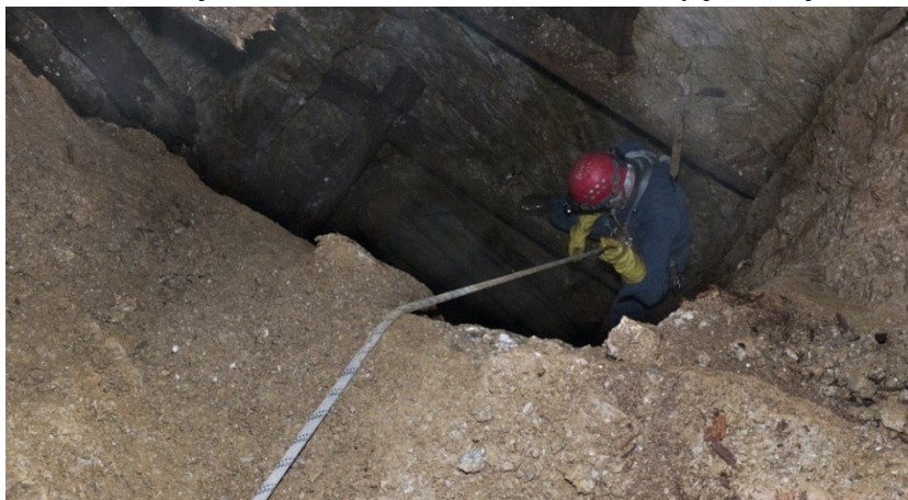
Čistění šachtice od staré stále ještě pevné výztuže
