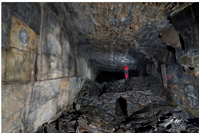
Obrázek 11 Komora v Dřevěné štole
