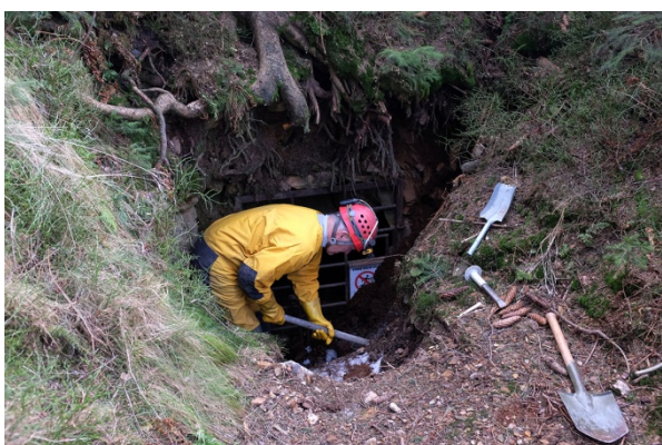
Obrázek 19 Vyzmáhání zavaleného vstupu
