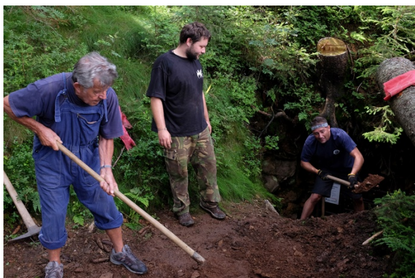
Obrázek 35 Zmáhání závalu vstupu do štolý Bleskovec II
