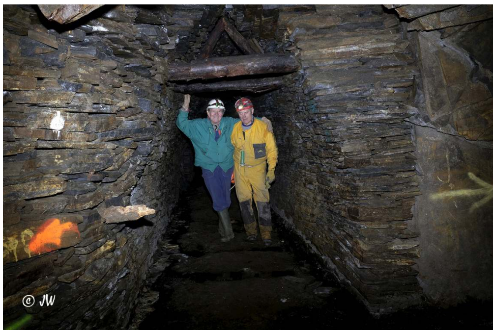
Obrázek 9 Kontrola v chodbách Polakovy štoly
