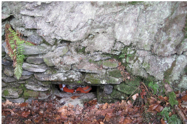
Obrázek 41 Vstup U Transformátoru I
