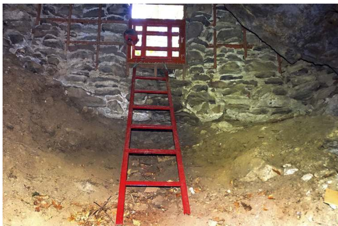
Obrázek 31 Opravený uzávěr vstupu do Franc Franc
