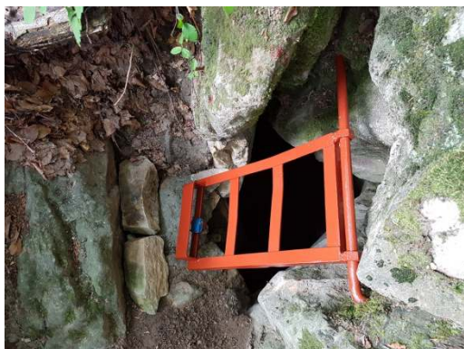
Obrázek 23 Opravený uzávěr vstupu do Zbojnické jeskyně
