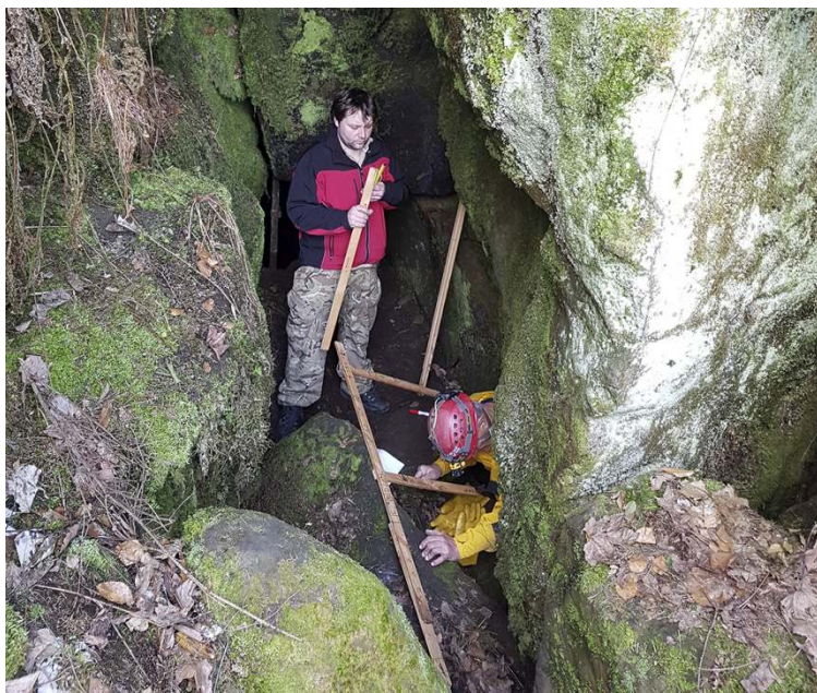
Obrázek 20 Zhotovení dřevěných uzávěrů pro výrobu mříží
