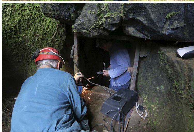
Obrázek 22 Provádění opravy a instalace nových uzávěrů vstupů do jeskyní na hřebenu Kopce.
