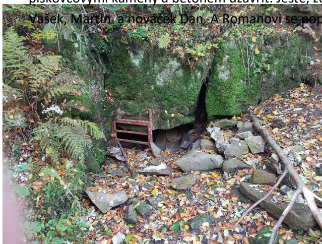
Tak to vypadalo před opravou
