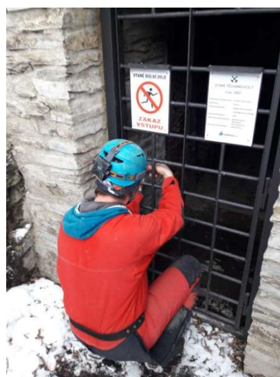
Obrázek 1 Nově vyzmáhaný vstup do štol Staré Těchanovice F
