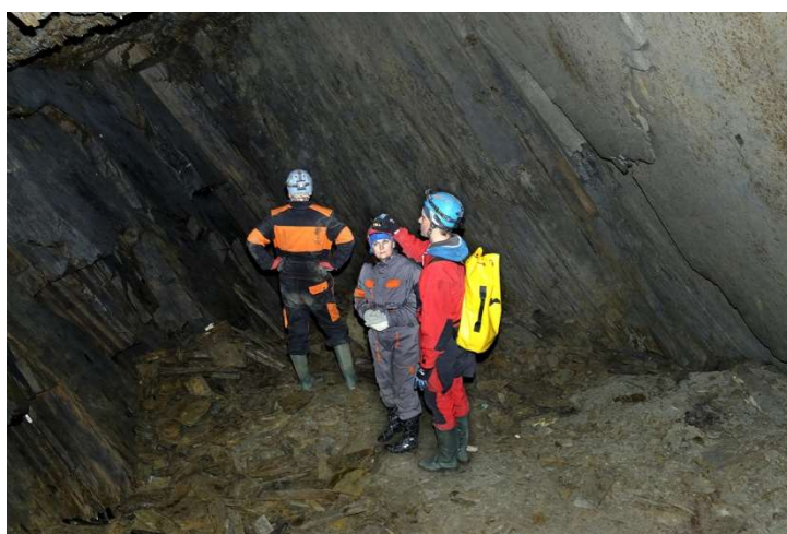
Obrázek 2 Kontrola ve štolě Obecní
