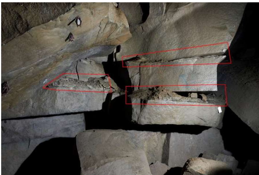
Poddajné vrstvy jílovců měly vliv na dynamiku pohybu v rozlamaných flyšových souvrstvích (vrstvy jílovců v Kněhyňské jeskyni)
