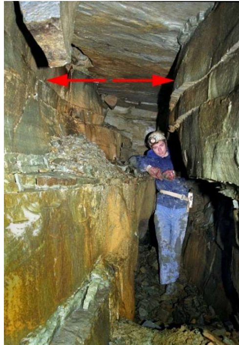
Rozšiřující se puklina za přispění podpovrchového ploužení a svahových procesů ve spodních partiích jeskyně Čertova díra
