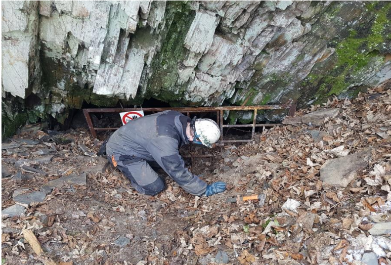
Vyklizení sutí ze vstupu do štol Zálužná dobývka A
