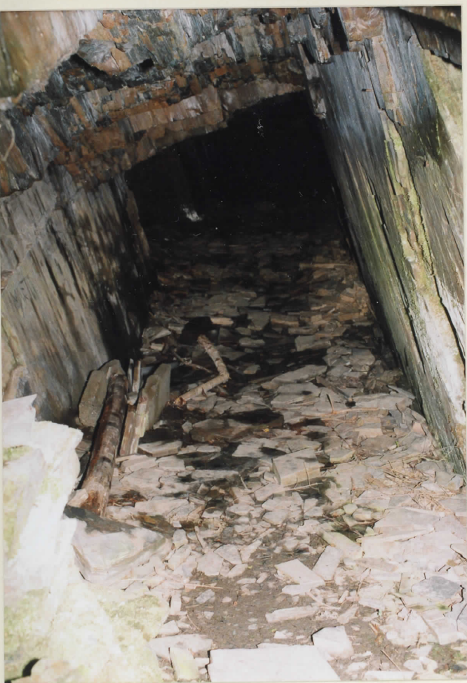
...Tak vypadal vstup před námi...
