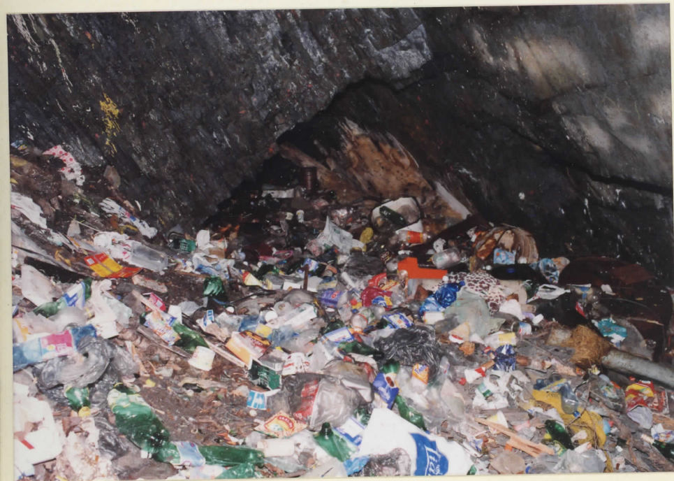
DNO VSTUPNI ŠACHTY ZALUŽNÉ
